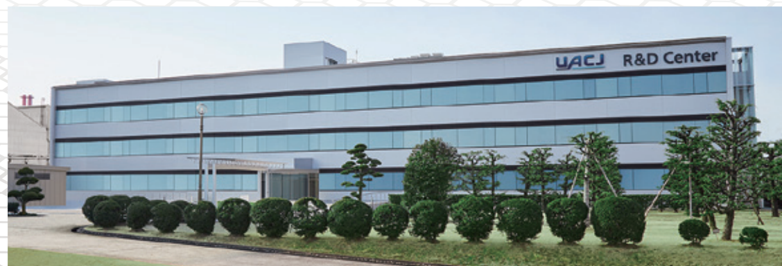
UACJ R&Dセンター／外壁
